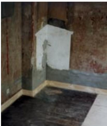
*Freigelegte Decken und Wände mit Putz ausgeflickt, der Fußboden teilweise erneuert. Jetzt beginnt die Selbsthilfe.*
